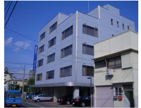
▲2 改装前 北西側外観
